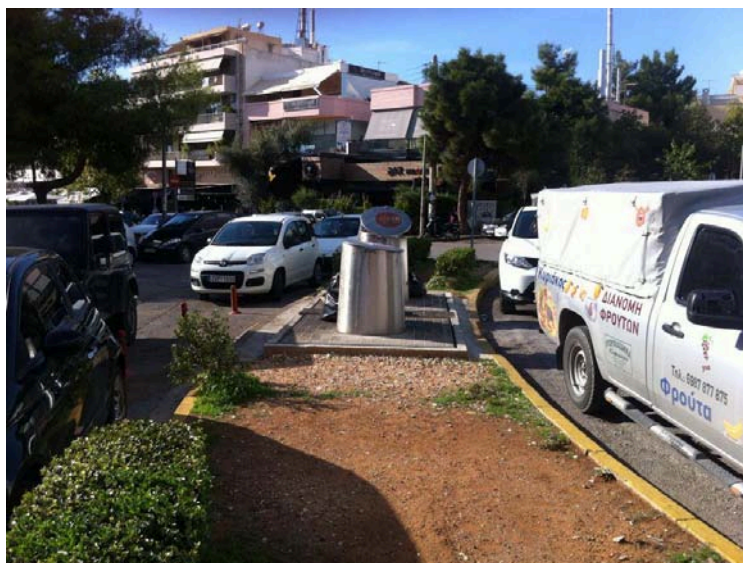
Εικόνα 5.2.2: Σύστημα υπόγειων κάδων συλλογής απορριμμάτων (Πλατεία Νυμφών).
