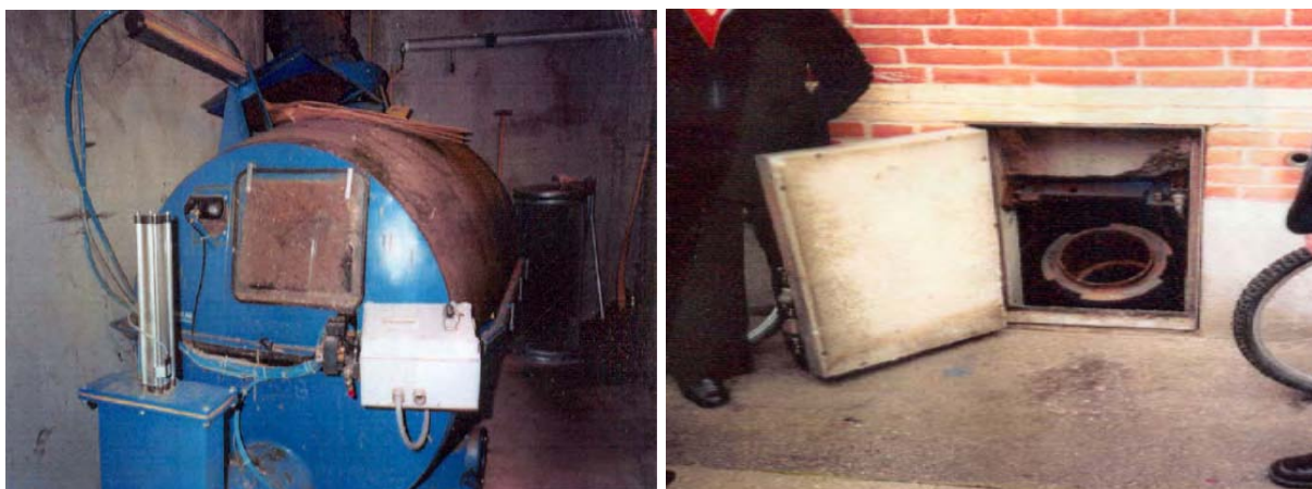
Εικόνα 5.10.3.2: Δεξαμενή συλλογής και θύρα αναρρόφησης
