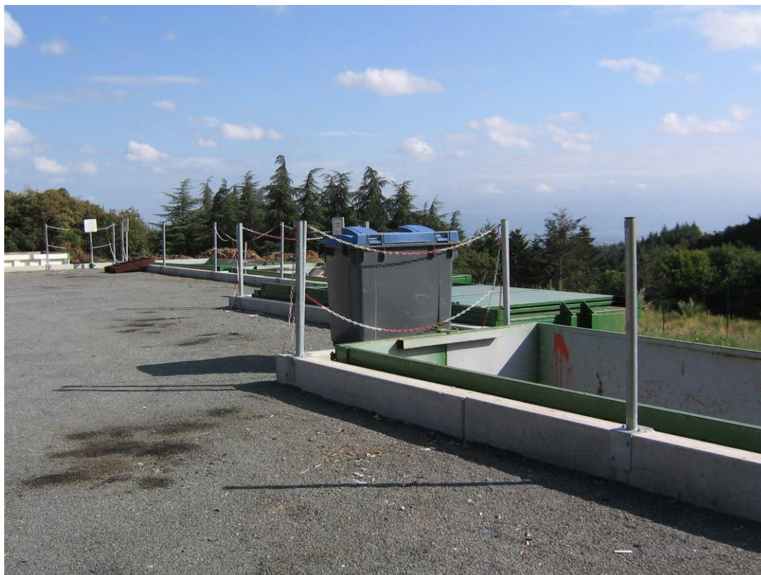
Εικόνα 2 - Άποψη χώρων προσωρινής αποθήκευσης
