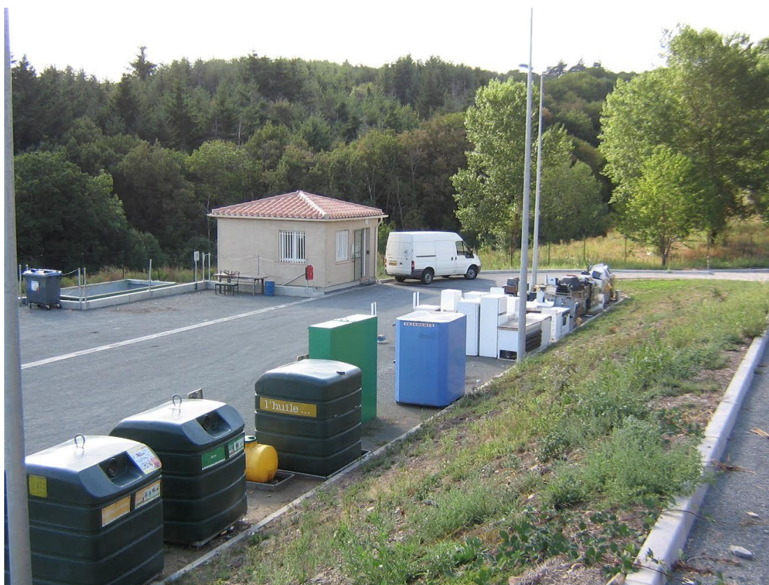
Εικόνα 12 - Γενική άποψη πλατείας και χώρου αποθήκευσης μικρών αποβλήτων
