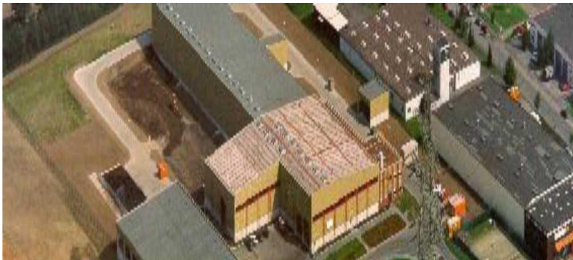
Εικόνα: Μονάδα κομποστοποίησης βιοαποβλητων (τύπου 2) στο Ντόρτμουντ (Γερμανία), δυναμικότητας 40.000 τον./έτος.
