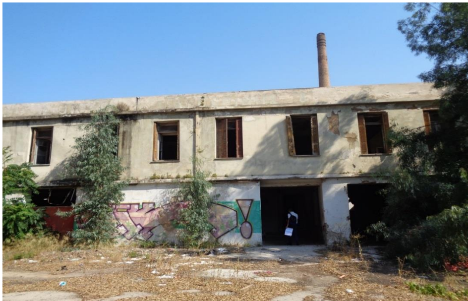
Εικόνα 35: Άποψη υφιστάμενης κτιριακής εγκατάστασης υποψήφιου οικοπέδου για τη χωροθέτηση κεντρικού πράσινου σημείου-ΚΑΕΔΙΣΠ Δήμου Μοσχάτου - Ταύρου, επί της οδού Πειραιώς, εντός της Δ.Ε. Μοσχάτου
