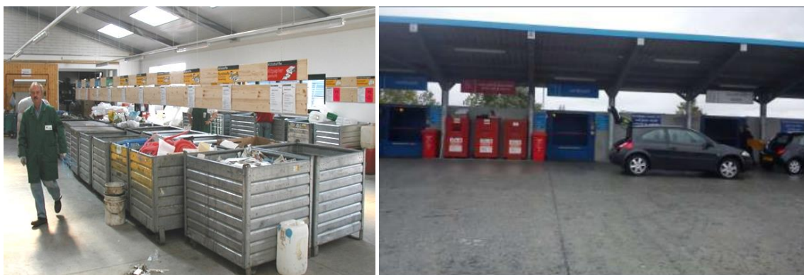
Εικόνα 16: Χώρος διαλογής μικρών ανακυκλώσιμων υλικών
