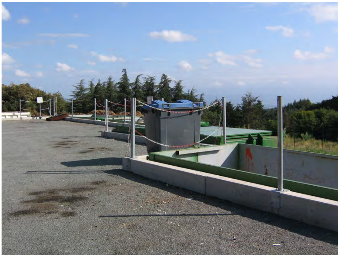
Εικόνα 3 - Άποψη χώρων προσωρινής αποθήκευσης
