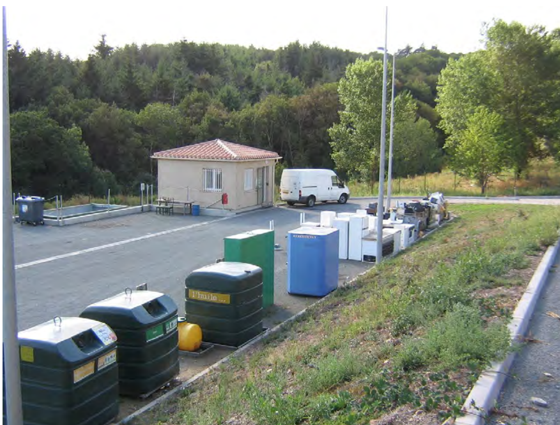
Εικόνα 13 - Γενική άποψη πλατείας και χώρου αποθήκευσης μικρών αποβλήτων
