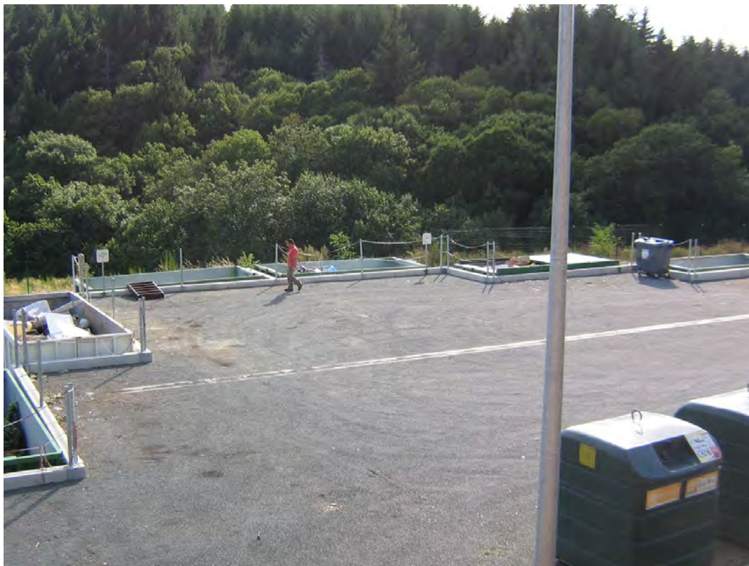
Εικόνα 12 - Γενική άποψη container
