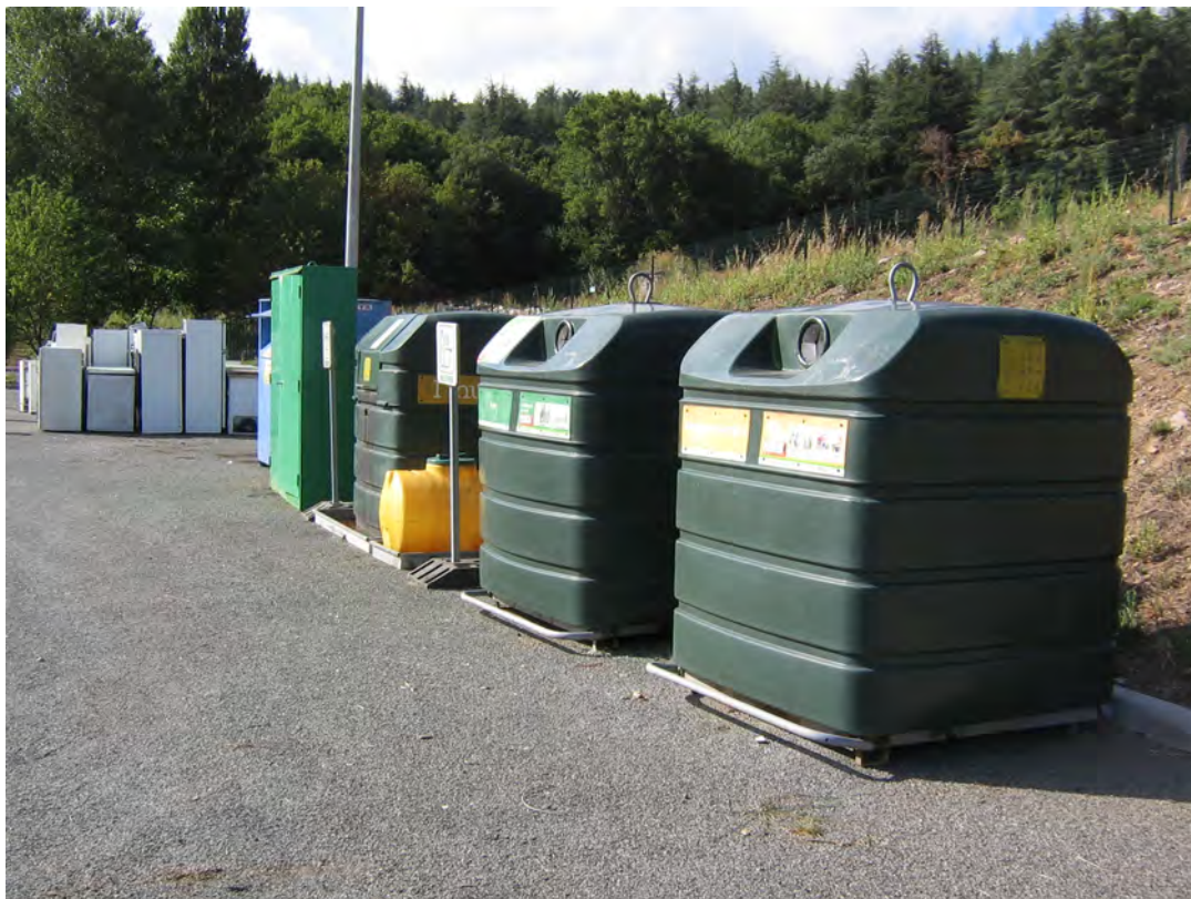
Εικόνα 8 - Γενική άποψη αποθηκευτικών δοχείων μικρών αποβλήτων
