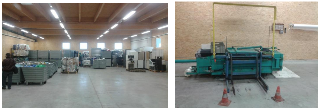
Εικόνα 19: Χώρος αποθήκευσης – συμπίεσης μικρών ανακυκλώσιμων αποβλήτων
