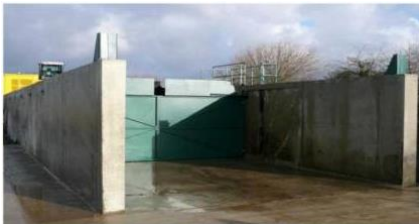
Εικόνα 10: Κανάλι κλειστού συστήματος κομποστοποίησης
