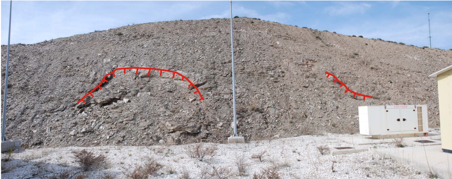
Φωτογραφία 4-6. Φαινόμενα αστάθειας στο τεχνητό πρανές ανάντη του Κτιρίου Διοίκησης. Σημειώνεται το περίγραμμα των θραύσεων.
