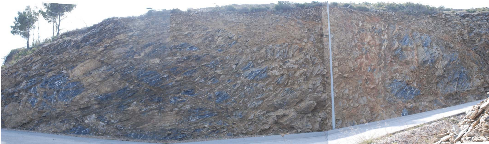
Φωτογραφία 4-4. Αποψη από βόρεια τεχνητού πρανούς του εσωτερικού οδικού δικτύου που διέρχεται βορειότερα του κλάδου της θέσης Α με τον οποίο αποτελεί κύκλωμα για την προσέγγιση του «κυτάρου Α» από την είσοδο των εγκαταστάσεων.
